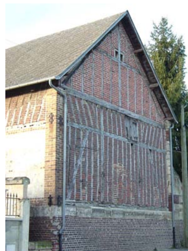
A Pimprez, exemple de colombage avec remplissage de brique
